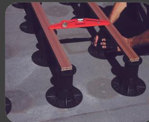
**5.** Sul travetto di sostegno fissare ad incastro il numero di teste necessarie in base al numero di supporti.
