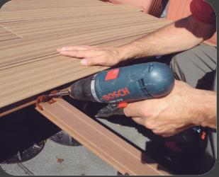
**9.** Una volta completata la struttura procedere alla posa dei listoni. Lungo il perimetro di testa è necessario lasciare almeno 5 mm. di aria per assorbire eventuali dilatazioni.
