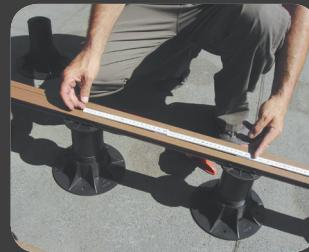
**1.** Il piano di posa dovrà essere quanto più possibile livellato e di consistenza sufficiente (fondo duro e compatto). La posa sui supporti in plastica regolabili in altezza, permetterà di ottenere una pavimentazione perfettamente piana anche in presenza di pendenze del piano di posa.
